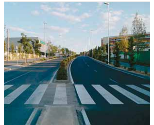
La calçada que s'ha eixamplat i la nova vorera del tram de l'avinguda, a la dreta de la imatge ■ EL PUNT AVUI
